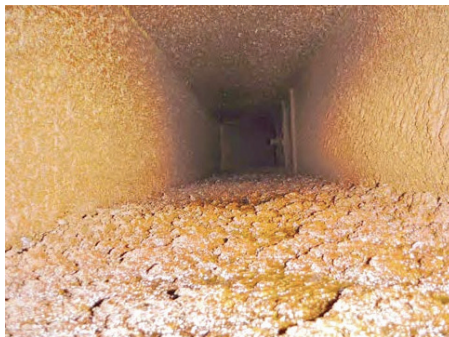
Фиг. 4. Наслоени мазнини по вътрешните стени на вентилационни канали
