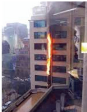
Фиг 1. Разпространение на горенето по кухненски вентилационен канал
