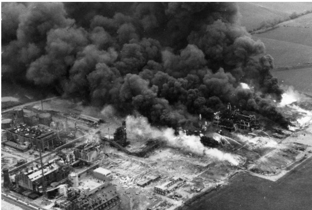
Сн. 3 Общ изглед на предприятието по време на аварията (близък план)
