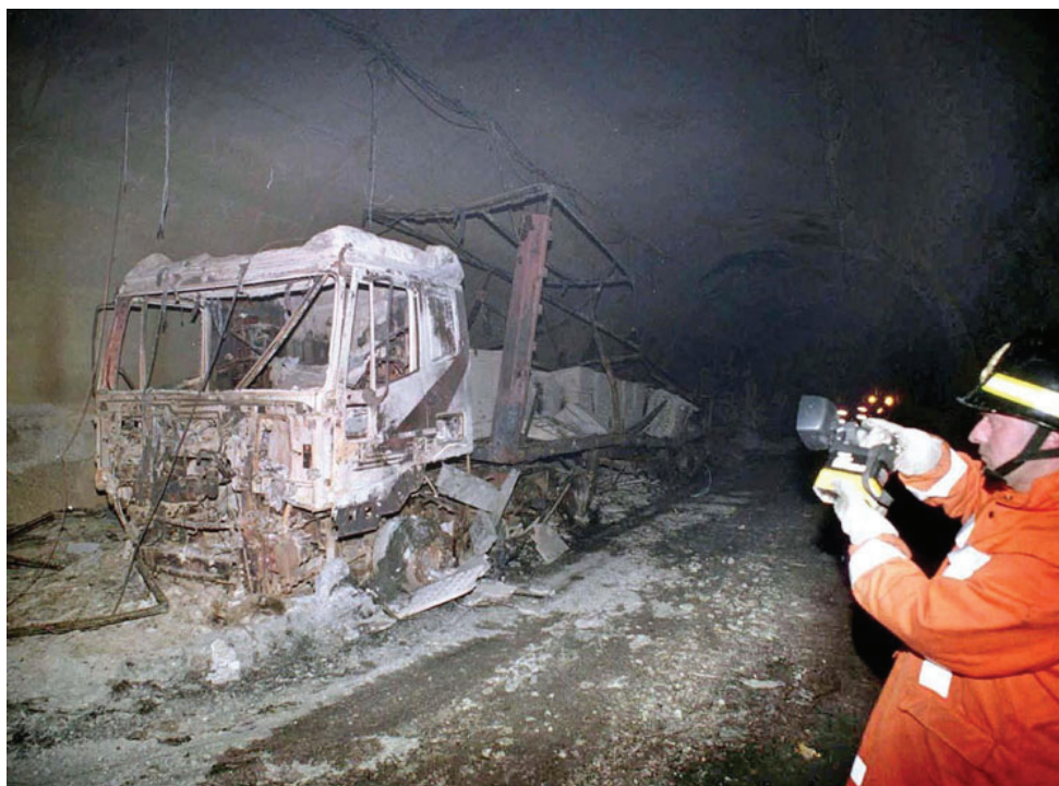
Сн. 3 Щети по тунела и автомобилите след пожара
