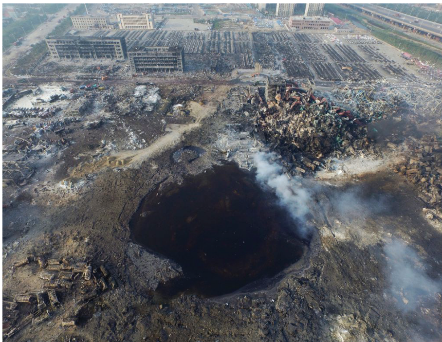
Сн. 3 Кратерът на мястото на най-голямата експлозия
