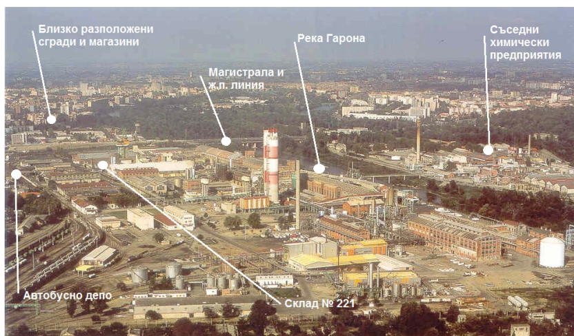
Сн. 1 Изглед към предприятието преди възникването на аварията
