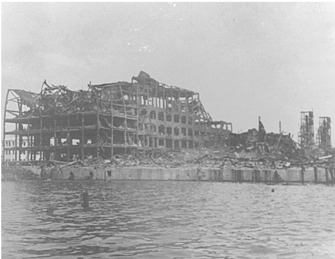
Сн. 13 Щети, вследствие от аварията
