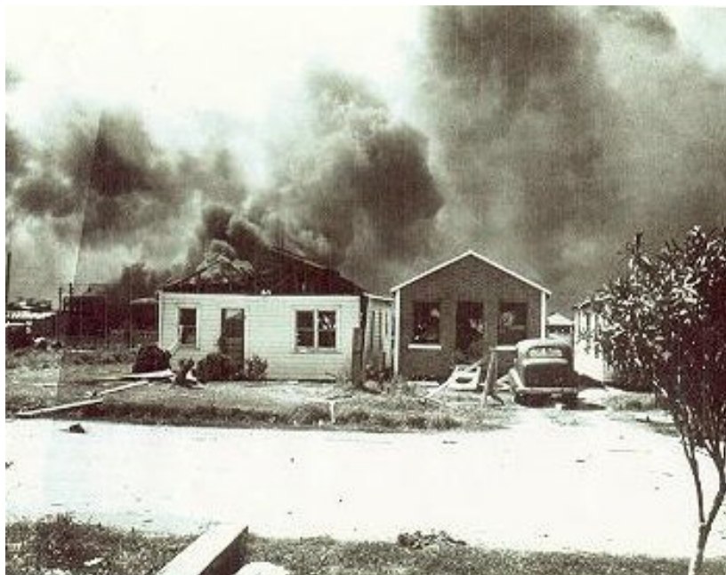
Сн. 5 Горящи жилищни сгради, вследствие от аварията
