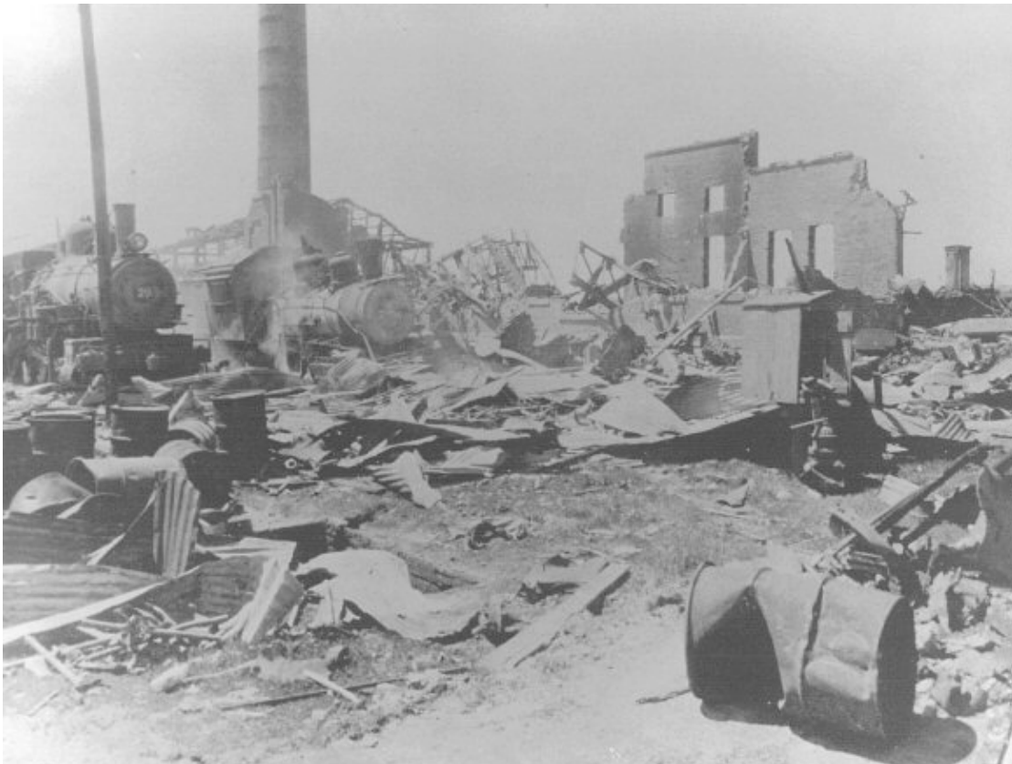
Сн. 14 Щети, вследствие от аварията
