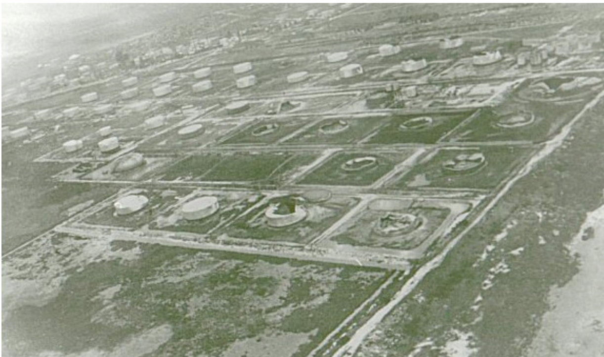
Сн. 15 Щети, вследствие от аварията
