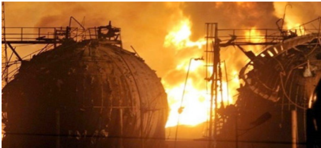
Сн. 1 Пожар, вследствие на експлозията
